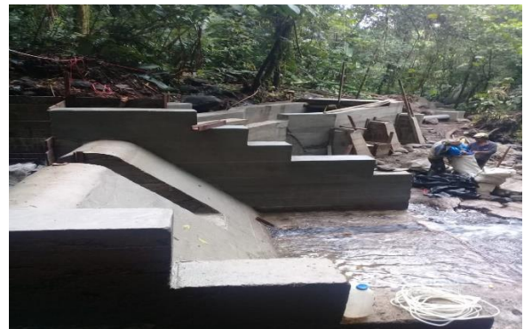
Gambar 9. Konstruksi bendung dan intake
