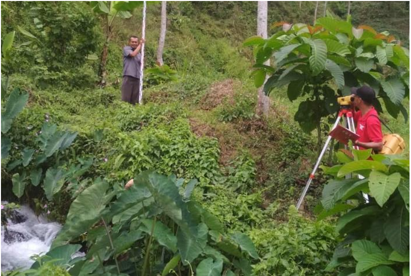
Gambar 5.4. Pengukuran beda tinggi pada survei potensi tenaga air menggunakan theodolit (Rahmanto & Wibowo, 2020)
