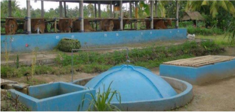
Gambar 9.4. Reaktor tipe fiber glass
