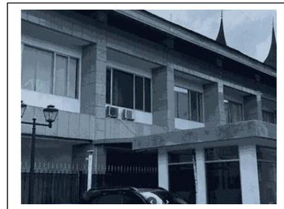
Penonjolan Balok dan kolom pada fasade sekaligus sebagai sun shading/tabir surya pada bangunan
