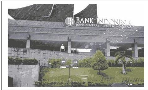
Pada teras muka bangunan menggunakan dak beton yang disangga oleh kolom pilotis untuk menciptakan area bayang bayang.
