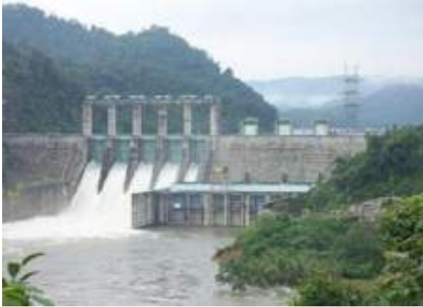
Gambar 9.1: Bendungan Pembangkit Listrik Tenaga Minihidro
