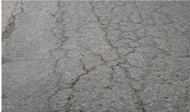
*Gambar 2. 1 Retak Kotak-kotak (Block Cracking)*
