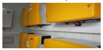
**Gambar 7.5:** Ventilasi Inverter / Solar Charge Controller dipastikan Bersih Tanaman Perdu serta Sampah (Esdm, 2017)
