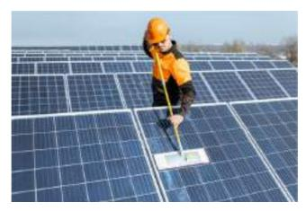
Gambar 1.5: Ilustrasi Pembersihan Permukaan Solar Panel (Canva.id, 2023)
