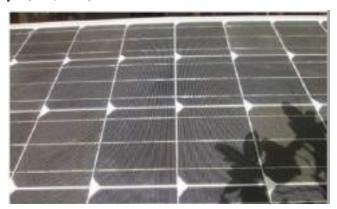
**Gambar 7.3:** Bayangan ranting Pohon yang Mengurangi Intensitas Cahaya Matahari ke Permukaan Modul Surya (Esdm, 2017)
