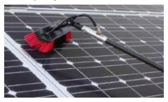
**Gambar 7.2:** Cara Pembersihan Modul Surya dengan Kombinasi Air Mengalir dan Penyikatan (Esdm, 2017)
